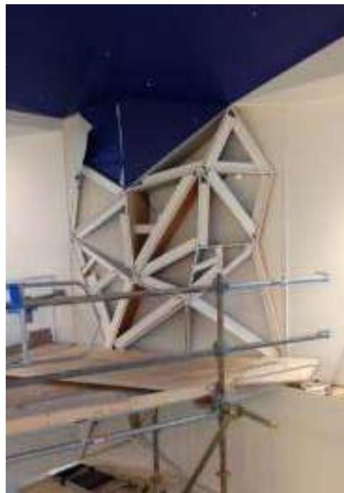
Bei diesem Projekt decken die Profile den oberen Teil des Haupttreppenhauses und die Decke des obersten Stockwerks ab. Sie wurden an einer Unterkonstruktion aus Holz und Metall befestigt, die nach einer CLIPSO-Werkstattzeichnung angefertigt und dann vor Ort von dem in den USA zugelassenen Verleger Fabric Wall Concepts hergestellt wurde.
