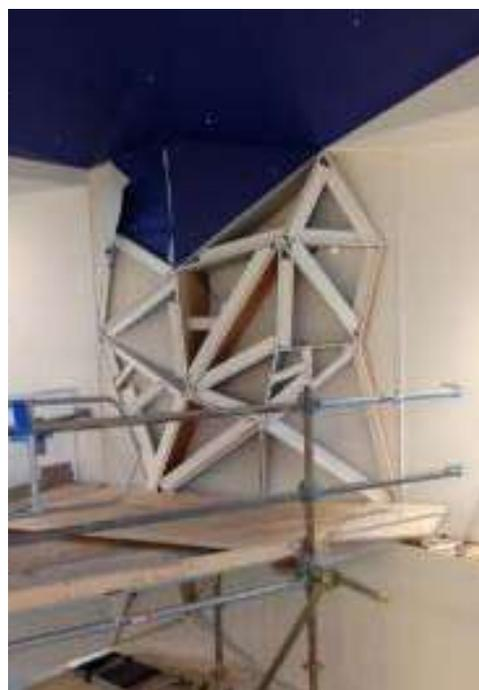
Dans le cadre de ce projet, les profilés couvrent la partie supérieure de la cage d'escalier principale et le plafond du dernier étage. Ils ont été fixés sur une sous-construction bois et métal réalisée à partir d'un dessin d'atelier CLIPSO® puis fabriquée sur place par l'installateur agréé aux USA : Fabric Wall Concepts.
