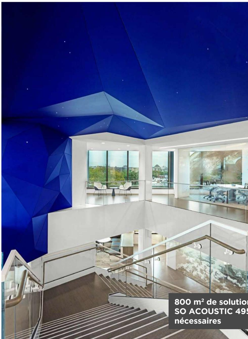
L'ossature structurelle devait être suffisamment rigide pour ne pas se déformer tout au long du processus d'installation, assez complexe, de toutes les surfaces adjacentes. Le plus grand défi étant d'obtenir un bordage de tissu propre lorsque jusqu'à six morceaux de profilés (P-CC blanc épaisseur 10 mm) se croisent en un seul point sur plusieurs plans différents.
