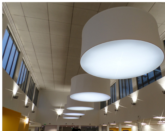
Centre commercial, France. Luminaires. ø 1,90 m. Ep. totale 800 mm. Revêtement couleur et translucide blanc. Intégration lumineuse.
