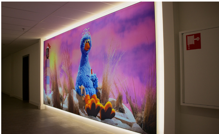
Bureau, Pays-Bas. Cadre mural rétroéclairé. Dim. : 4,60 m x 1,80 m. Ep. 140 mm. Revêtement translucide imprimé.
