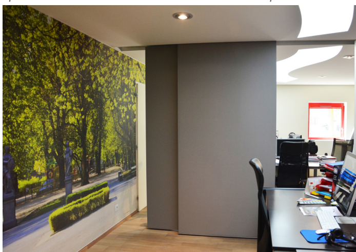
Bureaux, France. Cloison coulissante sur rail. Dim. : 1,20 m x 2,20 m. Ep. 100 mm. Revêtement couleur et absorbant acoustique.
