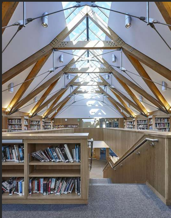
Bibliothèque - Royaume Uni - Plafond Acoustique Installation : ACOUSTIC GRG
