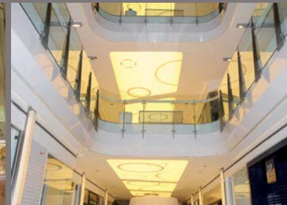
Bedruckte und hinterleuchtete Decken
