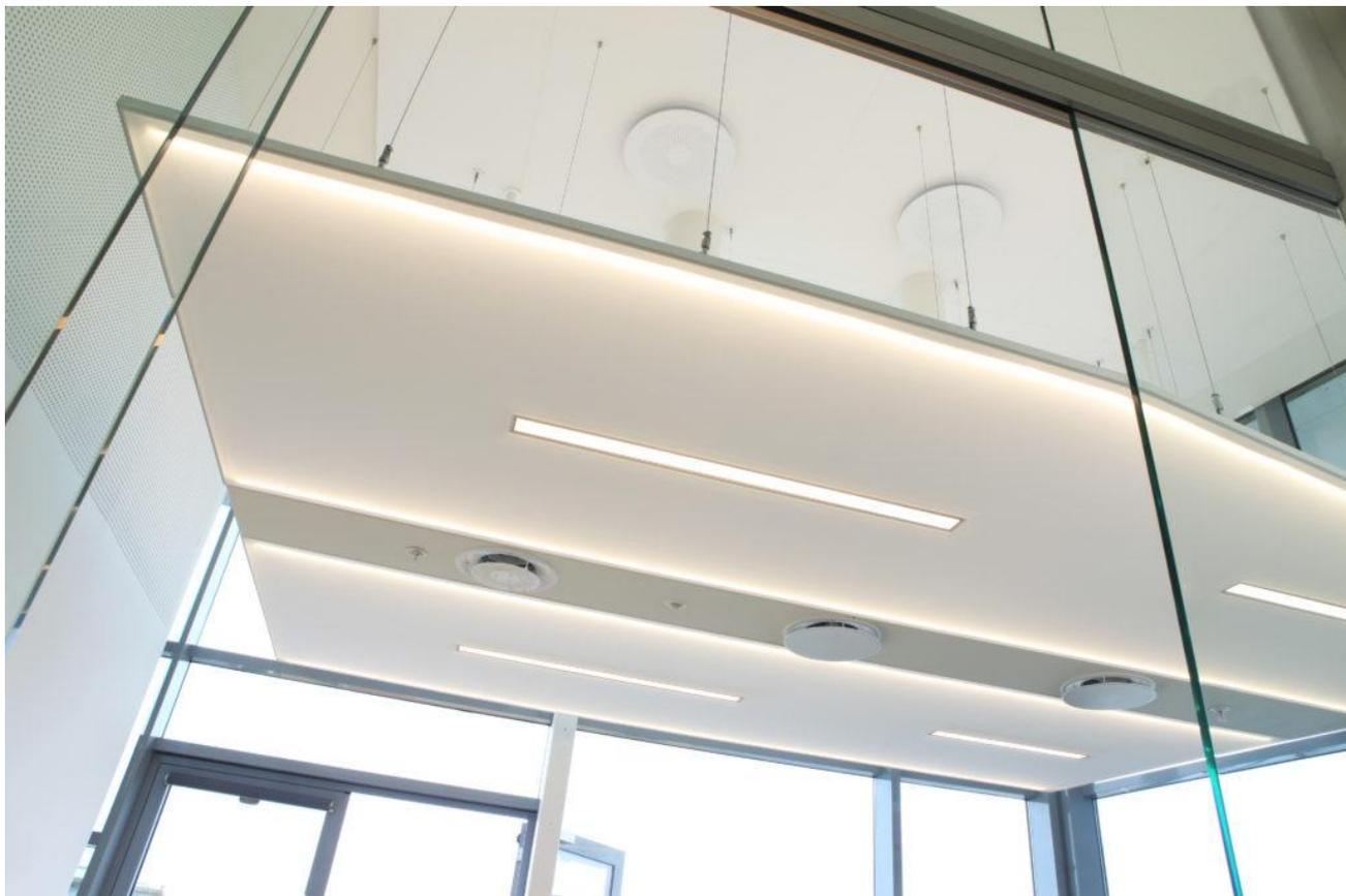
*Pour les bureaux et salles de réunion de Copenhague, 20 cadres de 4 configurations différentes et dont les tailles varient entre 1,5 x 2,4 mètres et 2 x 5 mètres ont été installés sans joints, ni coutures, ni soudure. La mise en œuvre à température ambiante et à sec (pas d'odeurs, pas de temps de séchage, très peu de poussières et de déchets) permet une mise à disposition des locaux rapide. Un procédé particulièrement adapté en milieu occupé, tels des bureaux.*
